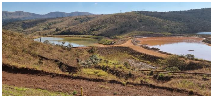
Vista geral das barragens B2 (a direita) de contenção de sedimentos) e B3 (a esquerda - de armazenamento de água), a partir de talude de barragem B1. Estas estruturas têm funcionamento combinado, sinérgico, sendo, desta forma, tratadas como uma estrutura individual.
