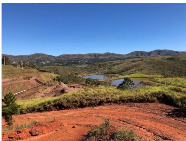
Vista geral das três barragens praticamente em série, B1, ao alto, objeto de retomada dos rejeitos antes retidos, B2 e B3, ambas com água, no fundo do vale.
