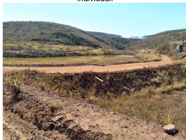
Reservatório da barragem B2, que foi objeto recente de desassoreamento. Ao término do próximo período de chuvas é recomendável a realização de novos serviços de limpeza.
