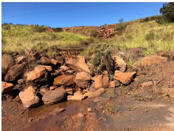
Canal de descida da B1 para a B2, enrocado com pedras e com outros dispositivos de amortecimento do fluxo de água.
